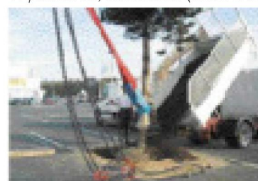
7. plantarea, ancorarea (daca e cazul) si completarea cu pamant
